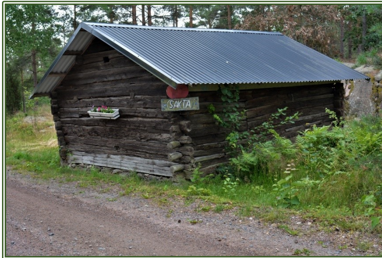
Ursprungstaket var täckt med björknäver, koskit, lera och stickor. Numera är det omlagt med s.k. bevarandetak
